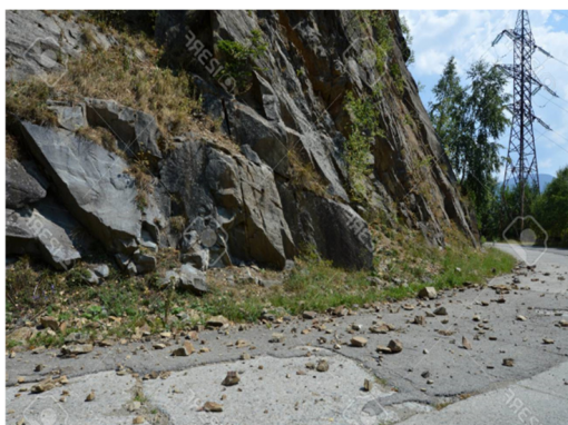
Ilustración 20: Depósitos de caída de baja intensidad. Fuente: kfv.at
